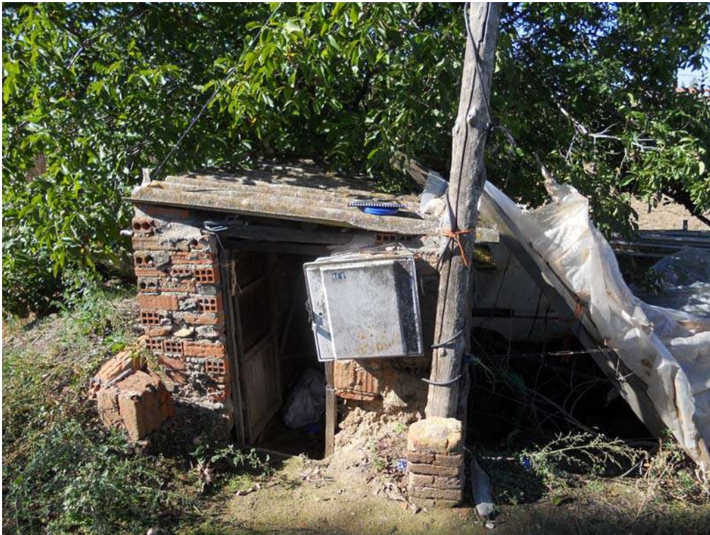
Foto 2: Pozo e instalación de bombeo
