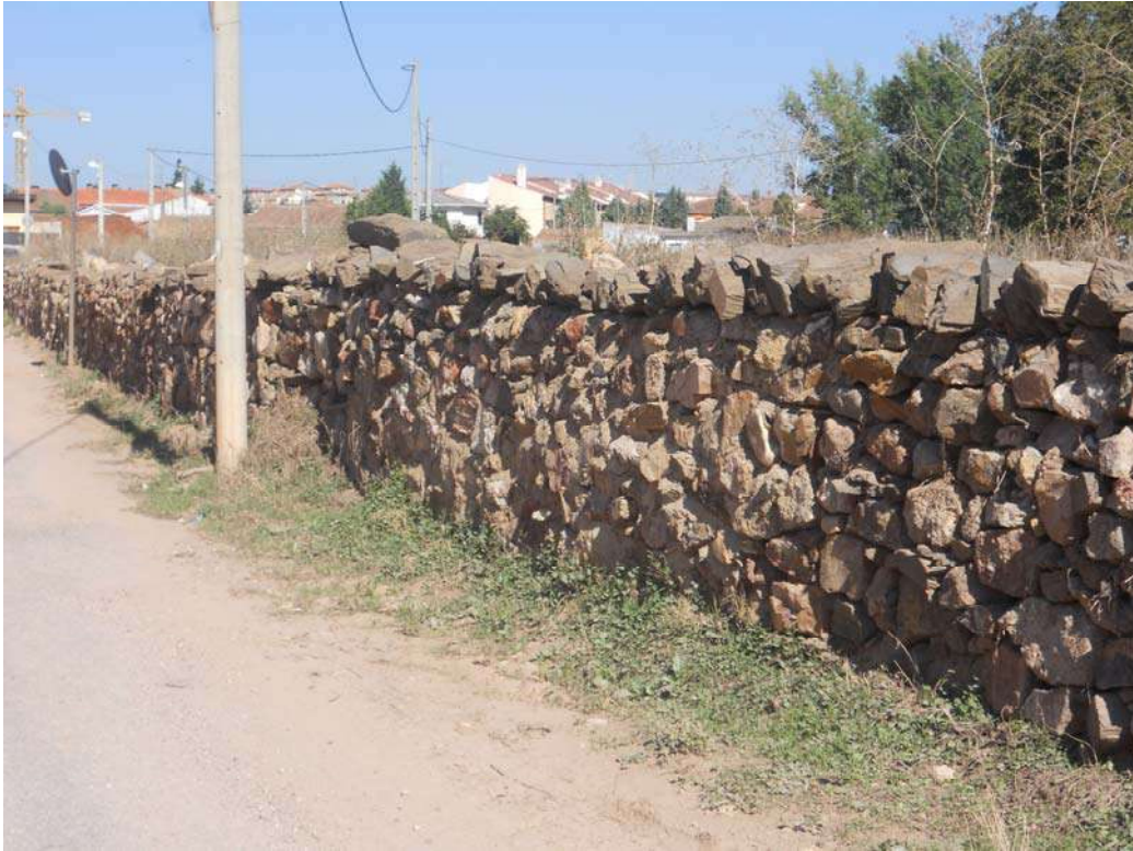
Foto 1: Muro de piedra
