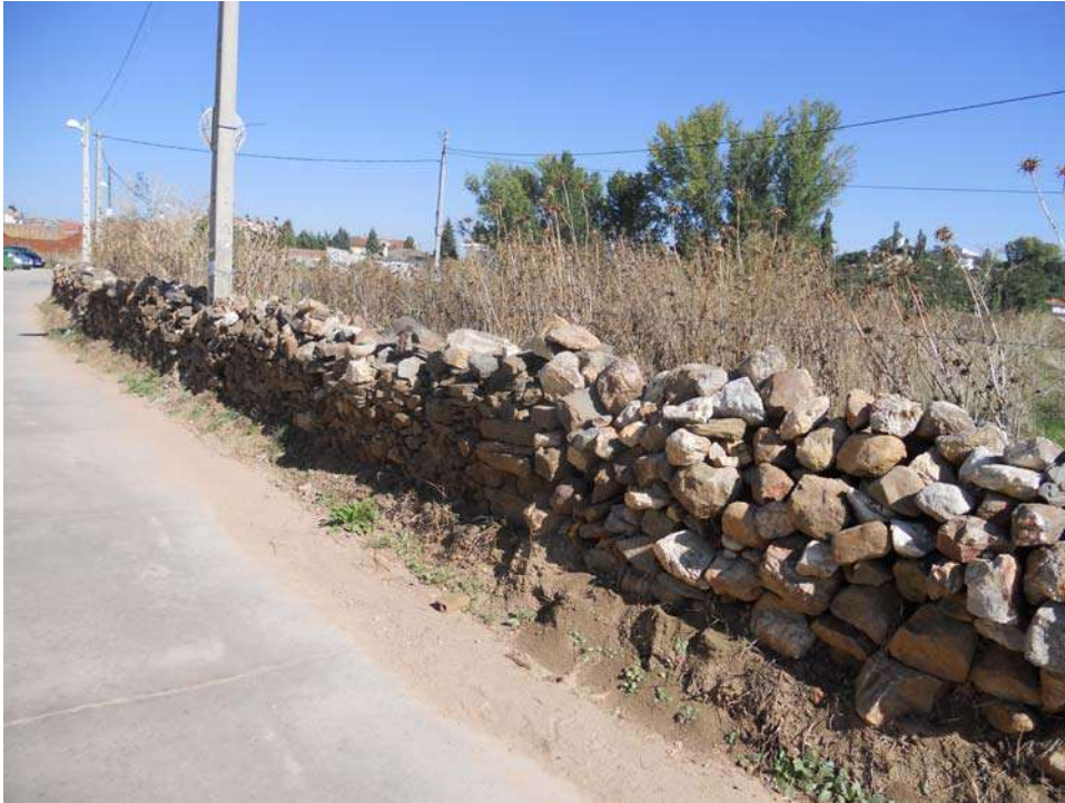
Foto 1: Muro de piedra
